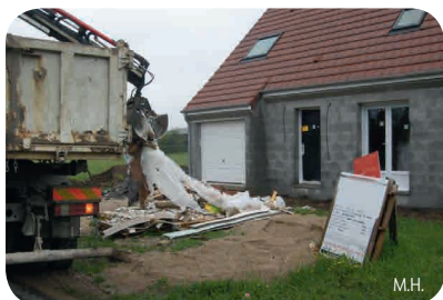
Evacuation de déchets de chantier par une entreprise spécialisée
